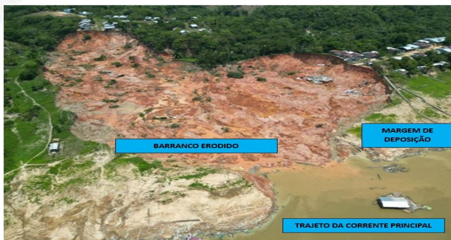
Figura 1 – Registro do afetamento de boçoroca na comunidade do Arumã em Beruri
