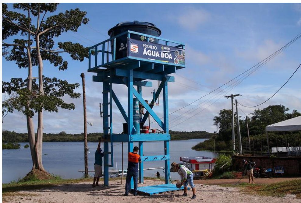
Figura 6 – Instalação do purificador de água na zona rural.
